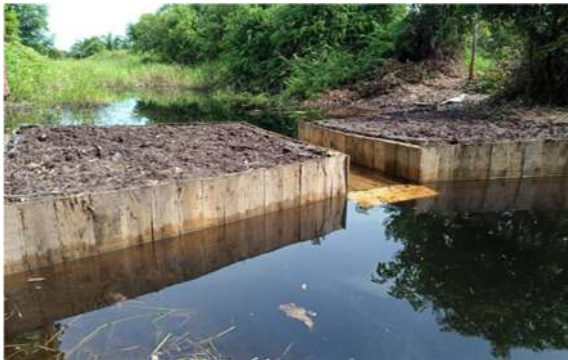
Gambar 8. Sekat Kanal di Kabupaten Pulang Pisau, Provinsi Kalimantan Tengah
