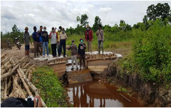
Gambar 10. Sekat Kanal di Kabupaten Pulang Pisau, Provinsi Kalimantan Tengah
