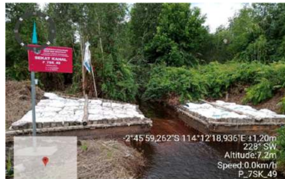
Gambar 9. Sekat Kanal di Kabupaten Pulang Pisau, Provinsi Kalimantan Tengah
