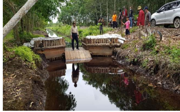
Gambar 11. Sekat Kanal di Kabupaten Pulang Pisau, Provinsi Kalimantan Tengah
